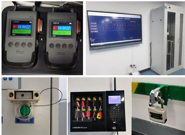
图4 高压供电设备防误操作闭锁系统
