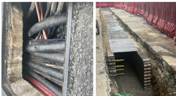
图5 户外低压电缆沟改造前与改造施工中
